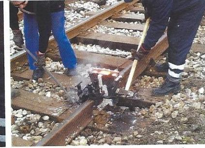
Slika lijevo: Uklanjanje posude za višak aluminijsko-termičkog liva.
