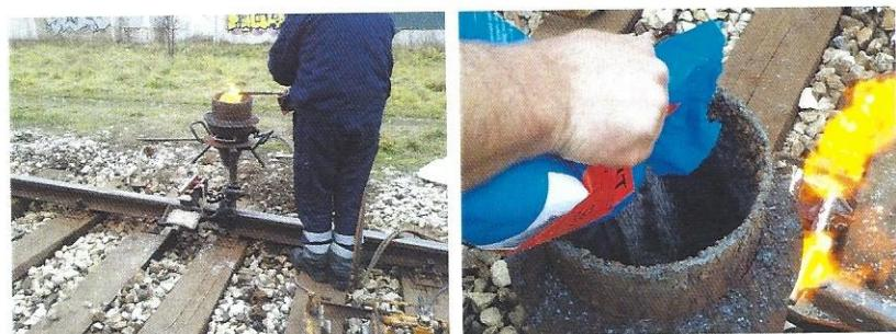
Slika lijevo: Zagrijavanje unutrašnosti radi boljeg paljenja i sagorijevanja termit smjese Slika Desno: Sipanje u termit smjese.
