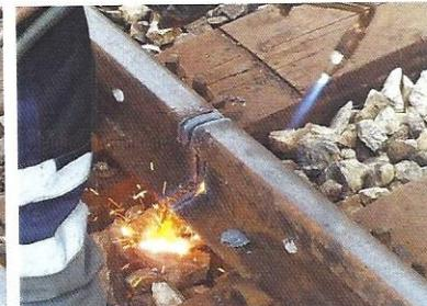
Slike lijevo i desno: Presijecanje željezničke šine radi proširivanja prostora pukotine na 25 mm što je neophodno radi uljevanja termitovog liva na mjesto zavarivanja.
