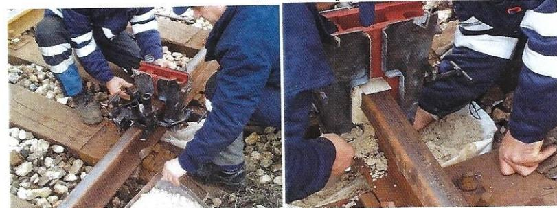
Slika lijevo Fiksiranje kalupa uz nosač lonaca za AT varenje. Slika desno: Diletaciono popunjavanje pijeskom žljebova između čeličnih oklopa.
