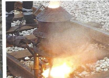
Slika lijevo: Ekspanzija sagorijevanja termit smjese. Slika desno: Topljenje patrona u lijevku lonca i početak izljevanja aluminijsko termičkog liva u šamotne kalupe na mjestu zavarivanja.
