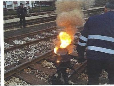
Slika lijevo: Povlačenje radnika na bezbjedono mjesto i početak sagorijevanja termit smjese u loncu za AT varenje. Slika desno: sagorijevanje smjese u loncu za AT varenje.
