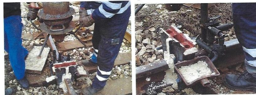
Slika lijevo: Postavljanje lonca za AT varenje na nosač. Slika desno: Isprobavanje mehanizma kretanja lonaca za postavljanje lijevka lonaca za AT varenje iznad šamotnog kalupa na šini.
