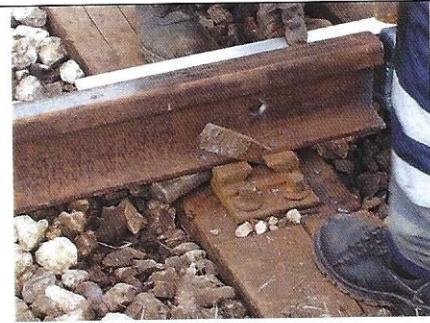
Čvrsto fiksiranje šine metalnim i drvenim kajlama
