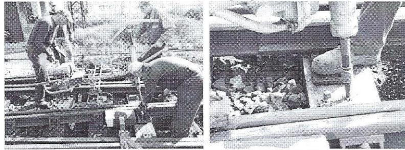
*Bušenje rupa i zavrtanje skretničkih podložnih pločica i trifon vijaka.*
