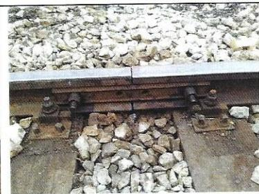
Slika lijevo: Mjesto puknuća željezničke šine. Slika desno: Željezne polužne vezice kojima je puknuta šina privremeno pričvršćena zbog potrebe odvijanja saobraćaja do aluminisko-termičkog zavarivanja željezničke šine.
