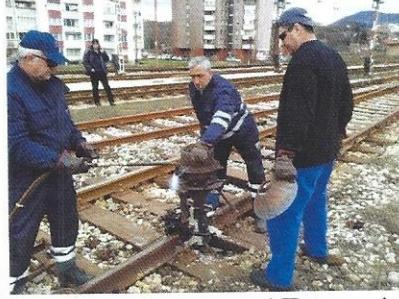
Slika lijevo: Postavljanje poklopca na lonac za AT varenje. Slikadesno: paljenje praskalice i ubacivanje u lonac za AT varenje.
