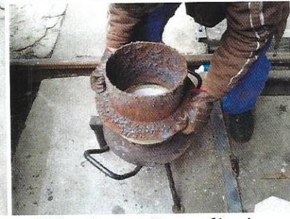
Slika lijevo: Gornje čelično okno. Slika desno: Postavljanje sa lijepljenjem gornjeg čeličnog okna na donje čelično okno i šamotni lijevak.
