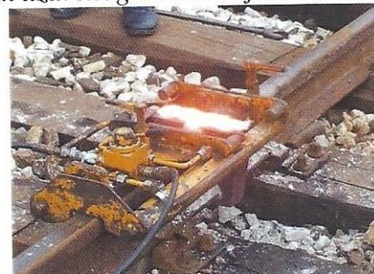
Slika desno: mašinsko uklanjanje ostatka liva na mjestu zavarivanja.
