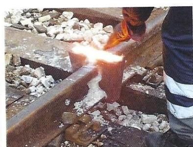
Slike desno i lijevo: Ručno uklanjanje šamotnog kalupa zajedno sa užarenim aluminijsko-termičkim lивom.
