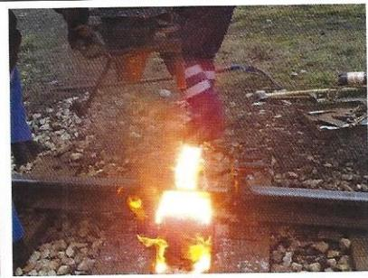
Slika lijevo: Punjenje šamotnih kalupa na mjestu zavarivanja aluminijsko tremičkim livom. Slika desno: Uklanjanje lonca za AT varenje iznad kalupa na mjestu za zavarivanje.
