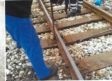
Slika lijevo: Zaštitna oprema varilaca za AT zavarivanje. Slika desno: Uklanjanje polužnih vezica sa mesta puknuća željezničke šine.
