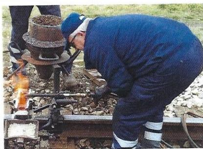
Slika lijevo: Termit smjesa nasuta u okno lonca za AT varenje. Slika desno: Zagrijavanje kalupa neposredno prije paljenja termit smjese.
