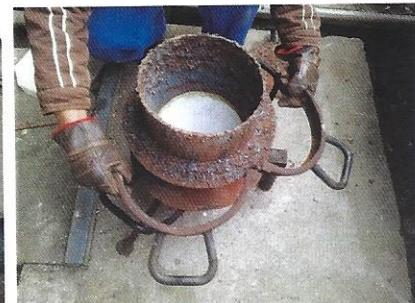
Slika lijevo: Obruč lonaca za AT varenje. Slika desno: Postavljanje oboruča lonaca za AT varenje na mjesto spoja i lijepljenja gornjeg čeličnog okna na donje čelično okno i šamotni lijevak.
