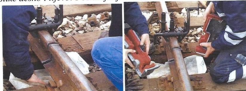
Slika lijevo: postavljanje najlona za sakupljanje pijeska. Slika desno: Šamotni kalupi za izливanje termitovog liva smješteni u čelične oklope.
