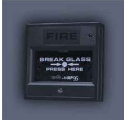
Slika 7. Ručni alarmni javljač požara 11
